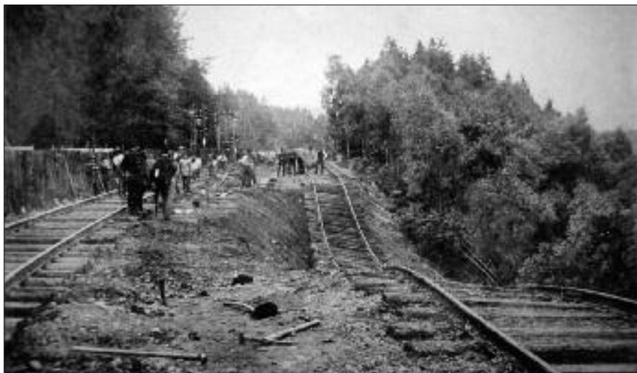
Dresdner Eisenbahnstrecke zwischen Flöha und Falkenau. Bergbruch im Juli 1909
